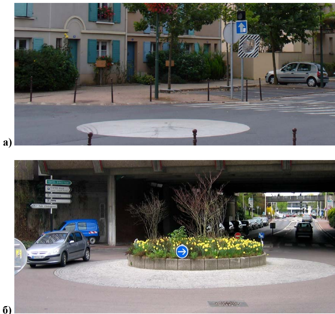
Рис. 2. Современные кольцевые пересечения в Сержи-Понтуаз (Парижская агломерация): а – мини-кольцо на жилой улице, центральный островок выделен разметкой; б – компактное кольцевое пересечение на территории общественно-торгового центра, вокруг островка устроена краевая полоса, выполненная мощением
